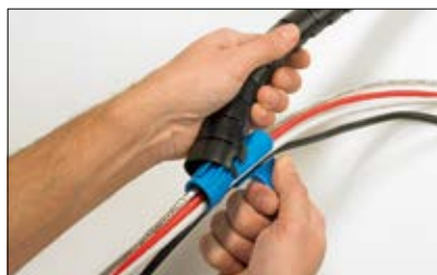
Helawrap wird nun nach dem Reißverschlussprinzip montiert.
