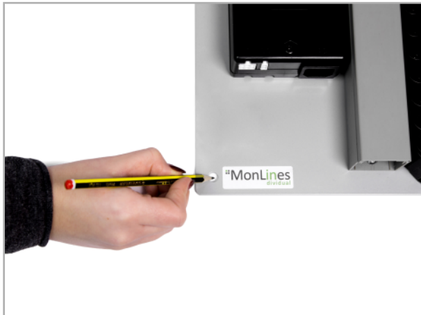
Abb. 2: Bohren und Anschrauben
